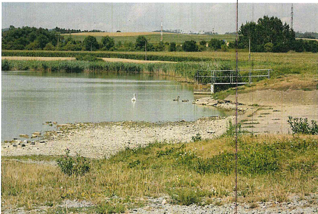
Pohled na výpustné zařízení s pochozí obslužnou lávkou, v popředí manipulační plocha kádíště a přepad z betonových panelů.
