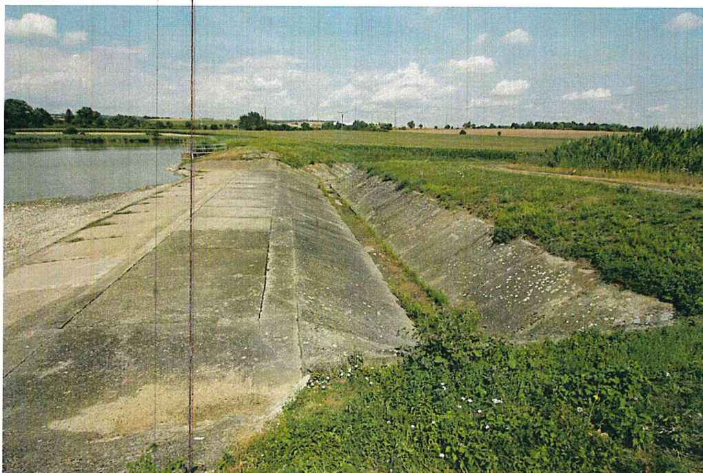
Betonový přepad a odpadní korytu za přelivem.
