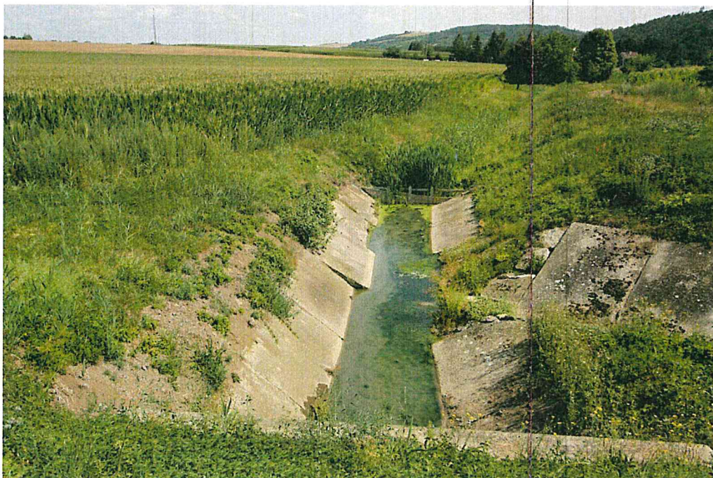
Odváděcí (odpadní) kanál pod výpustným zařízením, v pozadí porosty orobince širolistého v již přirozeném korytu potoka Výpustek.
